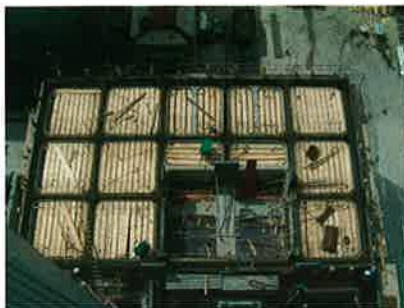
3 Beginn Gleitbeton © Peter und Lochner
