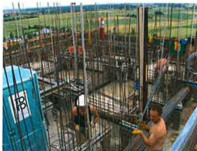
6 Bewehrungsarbeiten im Gleitbau © Peter und Lochner
